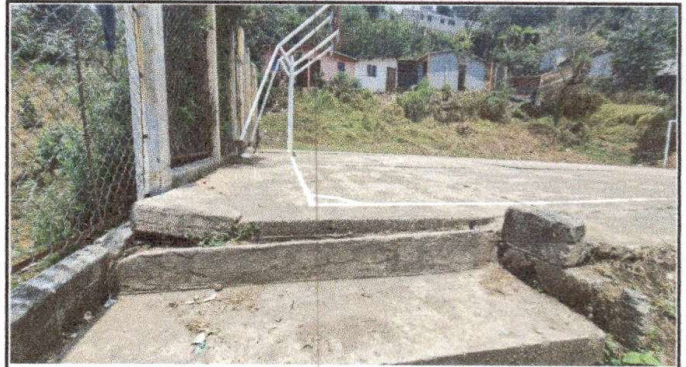
Foto 2: Sustrucción de piso de torta de concreto en cancha polideportiva
